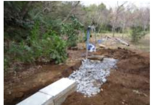
排水設備工事
